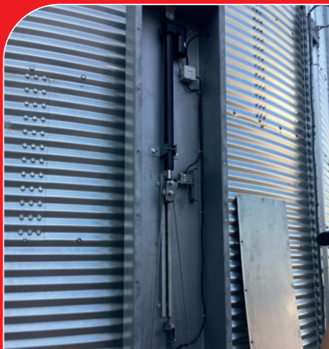
Option vérin électrique d'ouverture des trappes pour un séchage automatique. Contrôlé par un automate, à la fin du séchage, l'ouverture et la fermeture des trappes s'effectue en automatique.
