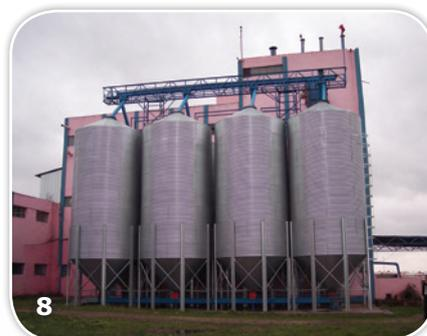
Les installations de stockage avec des cellules coniques sont des installations simples et efficaces. Génie civil simplifié, nettoyage facile, accès à la manutention de vidange sur toute sa longueur sont les principaux avantages qu'elles proposent.
